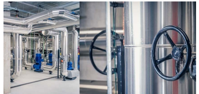
BROEN Ballomax®-Kugelhähne steuern den Durchfluss von Fernwärmewasser.
